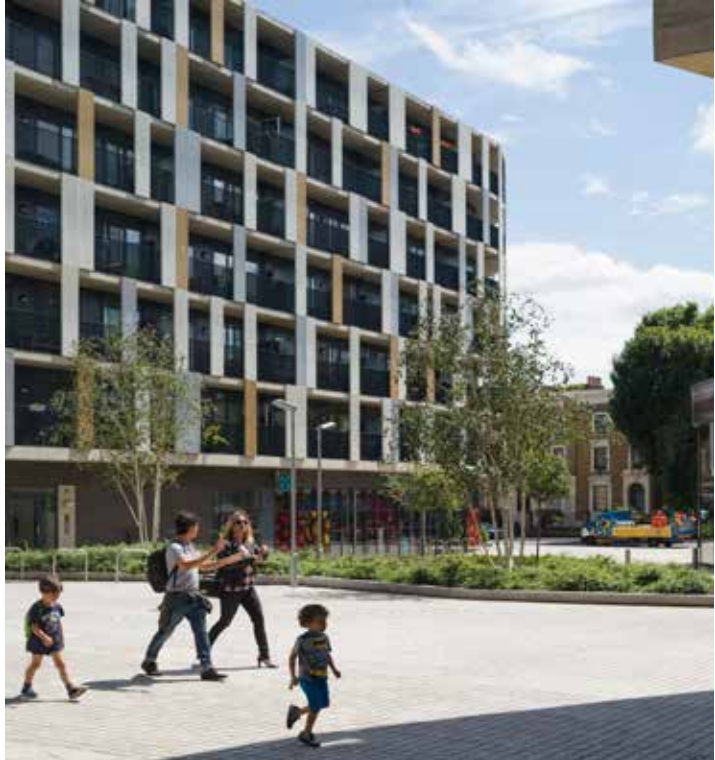
Pembury Circus / Hackney, FBM Architects
