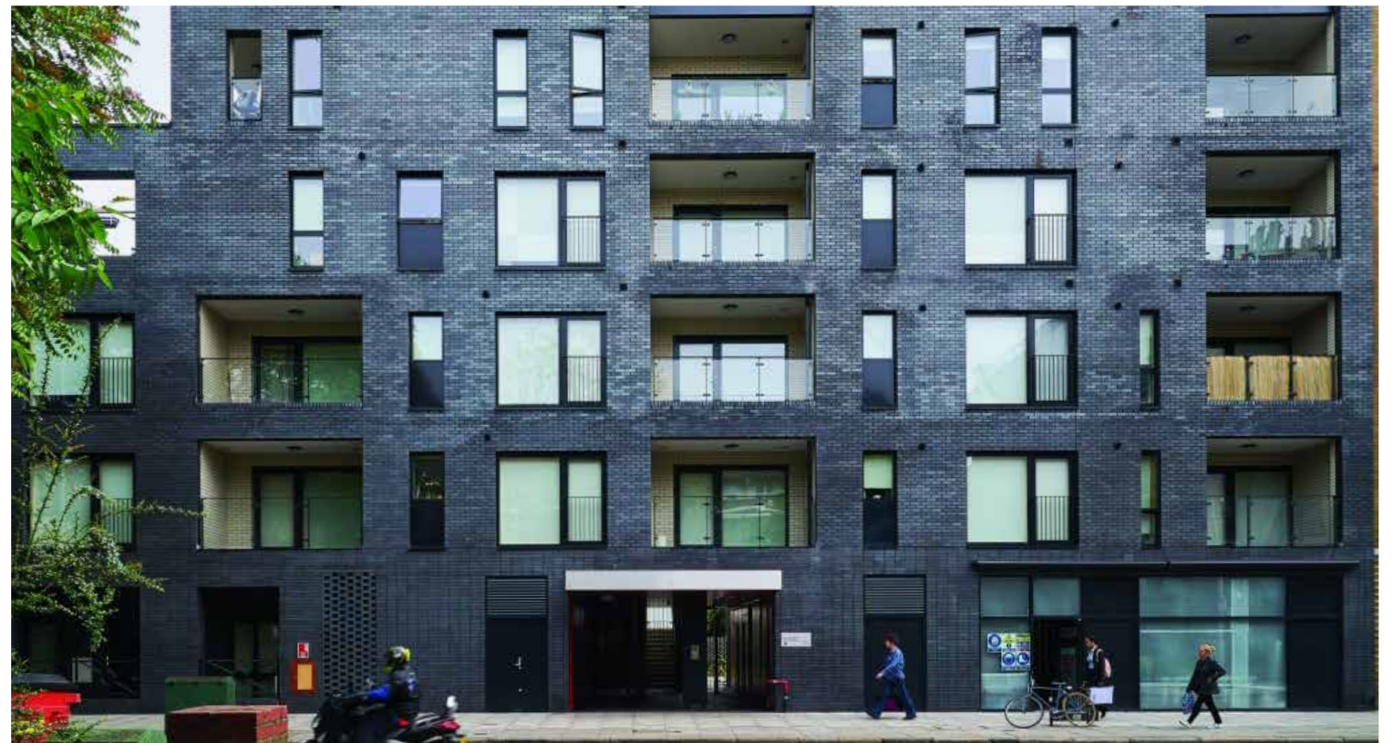
169 Long Lane / Long Lane, SE1
