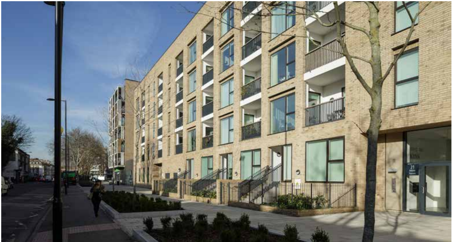
Pembury Circus / Hackney, FBM Architects
